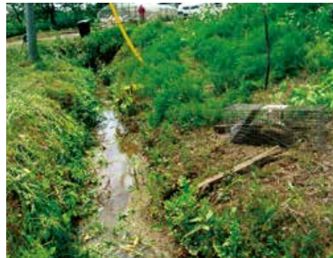
側溝や排水路
