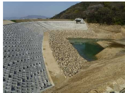
▲工事で発生した石材を法面保護材に再利用
