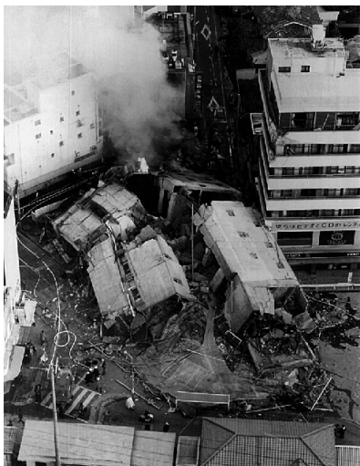
倒壊して道路をふさいだビル。兵庫県西宮市のJTB甲子園口駅北口で1995年1月17日
