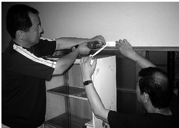
高齢者宅を訪れ、家具の転倒防止策を施す地域住民＝静岡市葵区で
