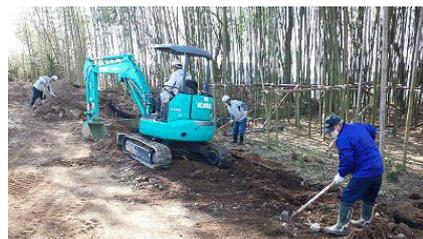
(5) 将来、竹の根が進入しないための「しゃへい板」の挿入作業
