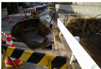
野間川 橋に流木等が掛り 越水して住宅地に浸水
