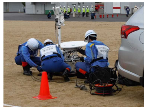
小型ポータブル衛星装置による 特設公衆電話設置訓練
