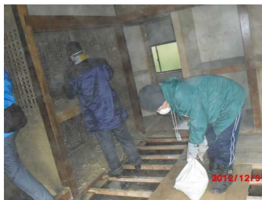
リフォームするため壁剥がしや泥落とし
