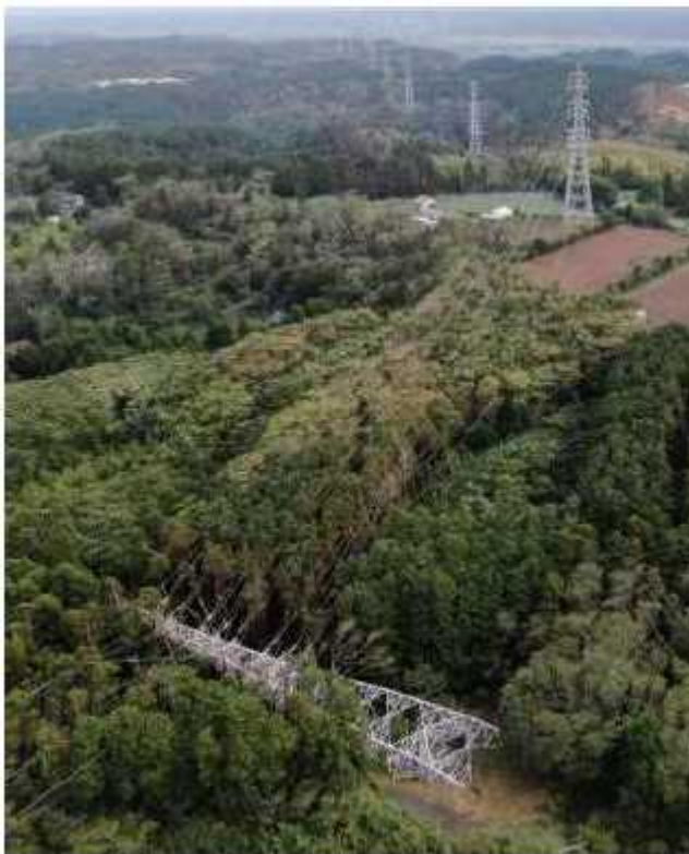
図3 主な災害時の被害写真の例 (令和元年房総半島台風、経済産業省提供)
