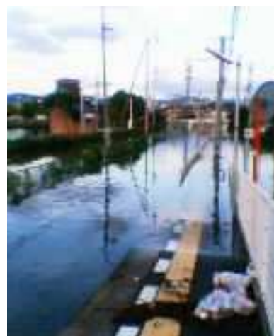
高潮状況琴電沖松島駅
