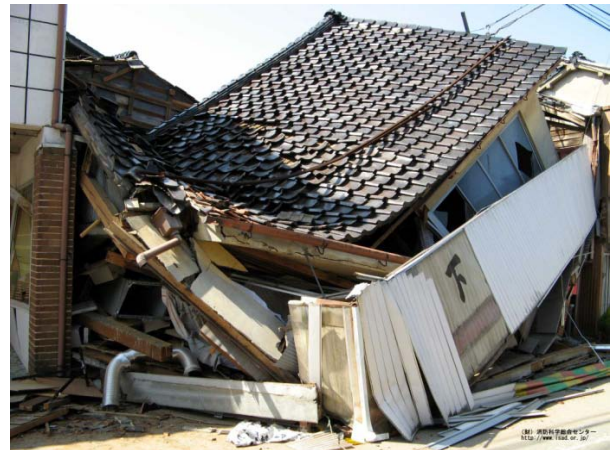
(中越地震(震度7)における倒壊事例)
