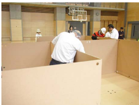
仕切り板組み立て（写真 6） ↓
