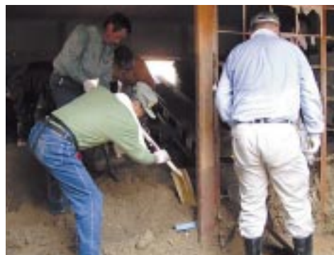
屋内に流入した土砂を除去するボランティア (さぬき市)
