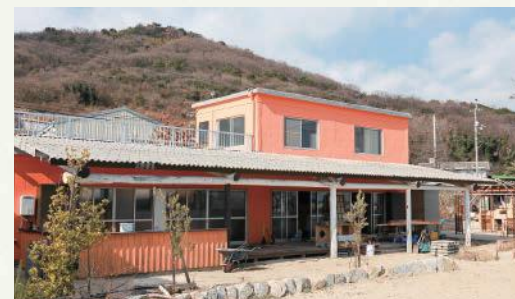
外国人向けのリーズナブルなゲストハウスを目指す。瀬戸内国際芸術祭2019春会期前のオープンを目指し急ピッチで工事を進める。
